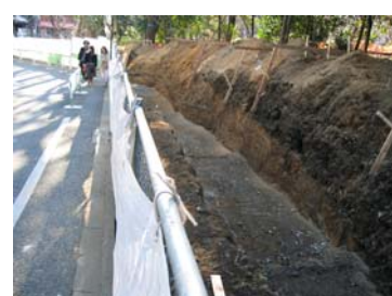
小石川植物園南東側工事現場
