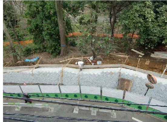
2012.03.25 御殿坂中央部【工事中】塀際の植物が塀の内側約5m無くなっている。
