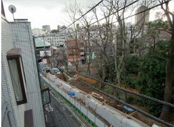
2012.03.25 御殿坂途中から坂下方向【工事中】塀際の樹木が伐採されて無くなっているのが分かる。
