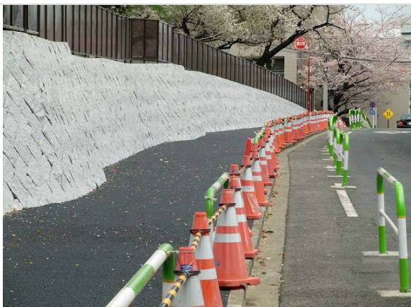
2012.04.11 御殿坂、中腹から上方向【工事終了後】植物園は新しい歩道の幅と擁壁の厚み分の幅が削られた。
