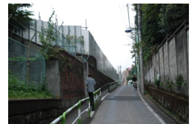
共同住宅が現在は建設されていないとしても、工事用の塀が存在する限り、将来的に道路事情などの変化によってその建設が復活するという可能性もある。左側に敷地の塀と右側に植物園。
